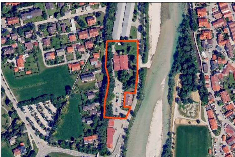
Orthophoto des Plangebietes und seiner Umgebung; rote Linie: Plangebiet des Bebauungsplanes „SO Hotelanlage an der Isar“
